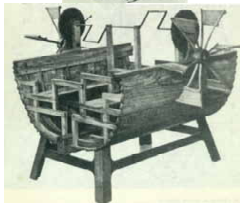
Fig. 6.30. Propulsie cu zbatouri perfecționată de Leonardo da Vinci (~1500).
